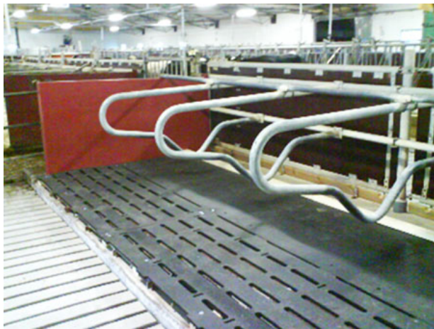
Figur 1 Sengebåse til ungtyre med spalter i de bagerste 80 cm, til dræning af urin (Foto: Anders Herlin)
